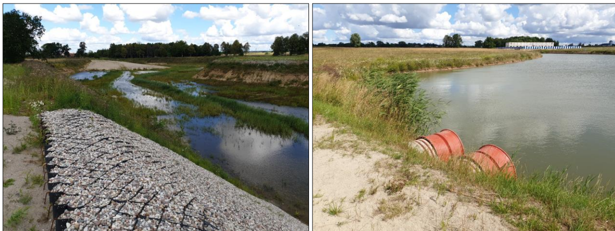
Рисунок 3.4: Пруд резервного запаса технической воды (слева); пожарный водоем (справа)
