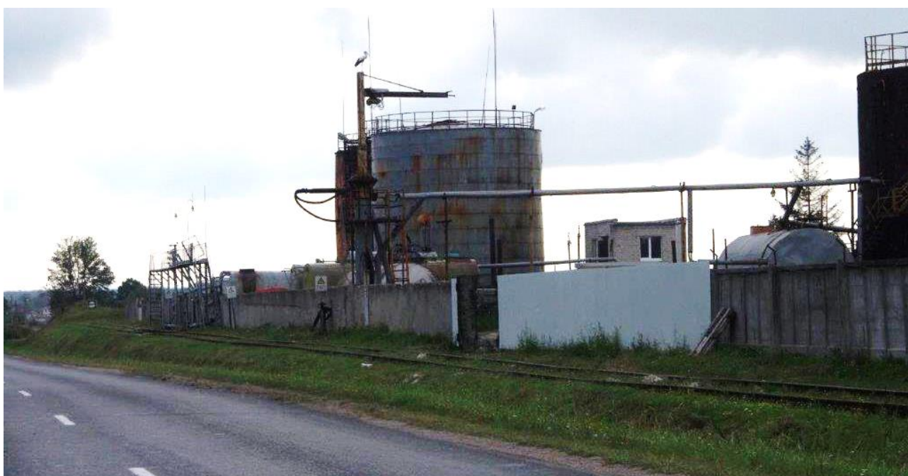
Рисунок 13-3 Асфальтово-бетонный завод в пос. Нивенское
