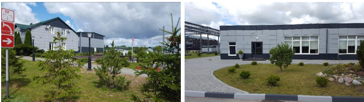
Рисунок 9.3.4: Участки благоустройства и озеленения на территории Административной площадки ООО «К-Поташ Сервис» - восстановленный почвенный покров используется в качестве субстрата для искусственной травянистой и древесно-кустарниковой растительности (фото Ramboll)
