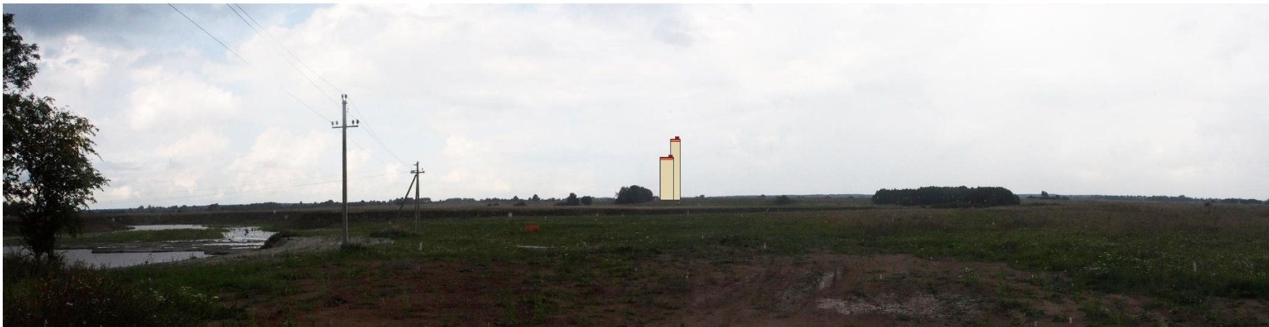
Рисунок 9.4.3: Вид на площадку ГОК с обзорной точки KPL3
