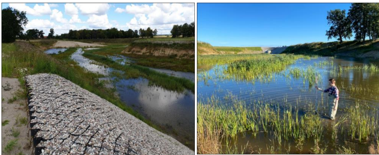
Рисунок 7.3.12 – Пруд резервного запаса воды: Приплотинная часть пруда (слева); промеры в пруду (справа)
