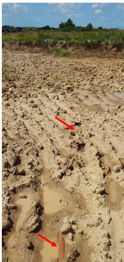
Рисунок 7.5.8 – Одна из линий гончарного закрытого дренажа на участке инженерной подготовки для проектируемого размещения объектов Нивенского ГОК (Фото Ramboll)
